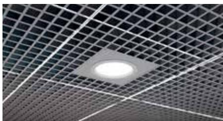
**Установка светильника с переходником 600x600**
