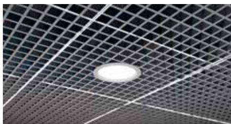
**Установка светильника с переходником 300x300**
